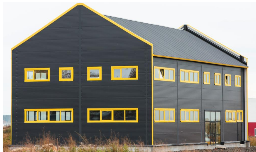
Производственное здание «Зибус»
