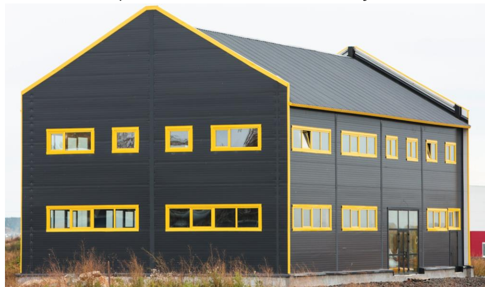
Производственное здание «Зибус»
