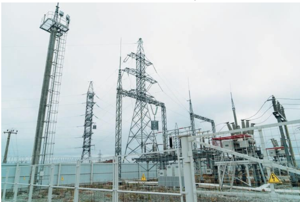
Substation «Titan» 110/10 kV
